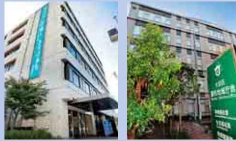
大森地域庁舎 Omori Area Office / 大森地区庁舎 / 오모리 지역청사
